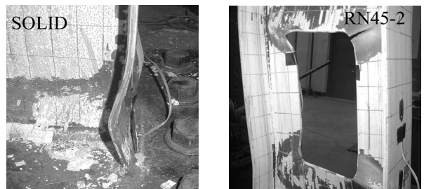
그림 8. 단부 국부좌굴 양상 및 개구부 균열 형상
