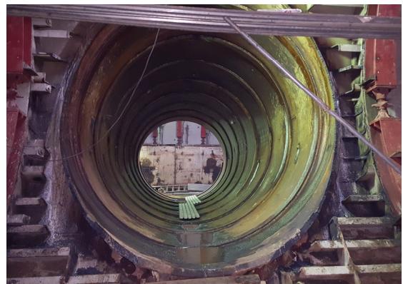
(d) Completion of thrust the steel pipe
