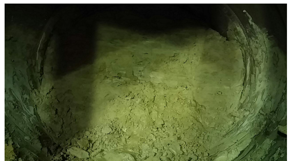
(d) Cross-connection tunnel 1 (04/29/16)
