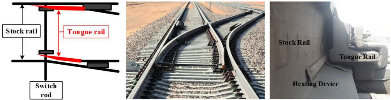
그림 1 철도 레일 분기기 Fig. 1 Railway switch
