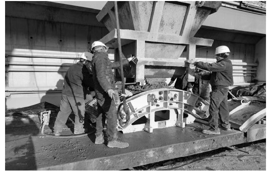
(b) Concrete pour
