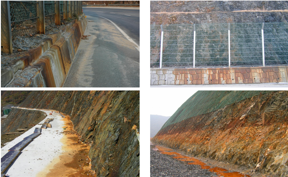
Fig. 2. 충북 B지역에서 발생하는 ARD 및 황화광물 산화작용 흔적.
